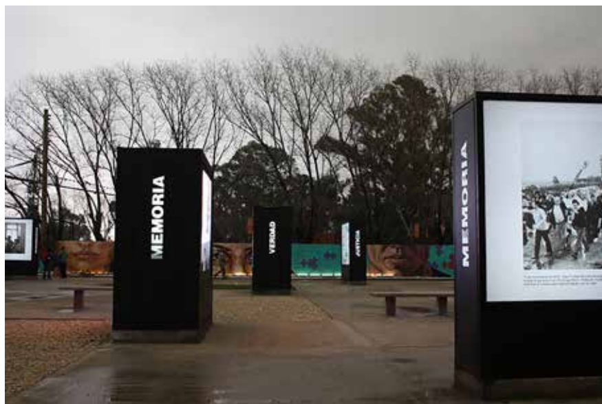
Construcción de la Plaza de la Memoria que forma parte de la Muestra de Ciencia y Técnica, Tecnópolis. Provincia de Buenos Aires.
