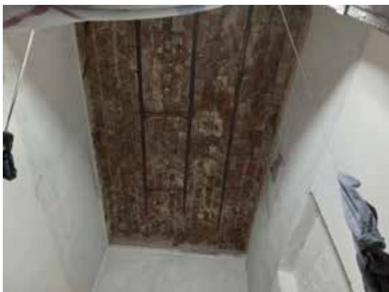
Techo de una celda Alcaldía 3 Anexo A
