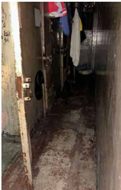
Pasillo entre celdas Alcaldía 1 Bis Anexo
