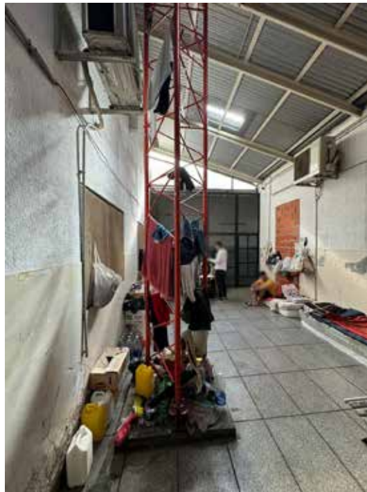
Pasillo de la CV 1B
